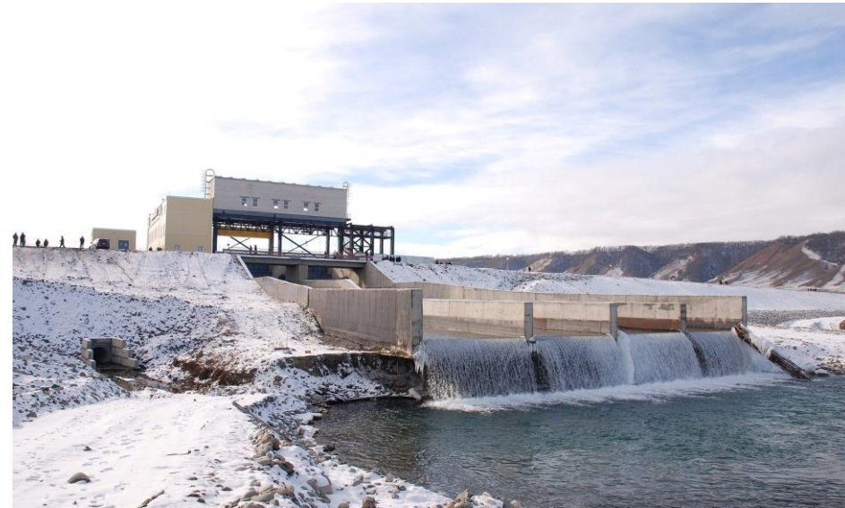
Малая гидроэлектростанция мощностью 1,26 МВт в Карачаево–Черкесии (Россия), построенная на реке Большой Зеленчук
